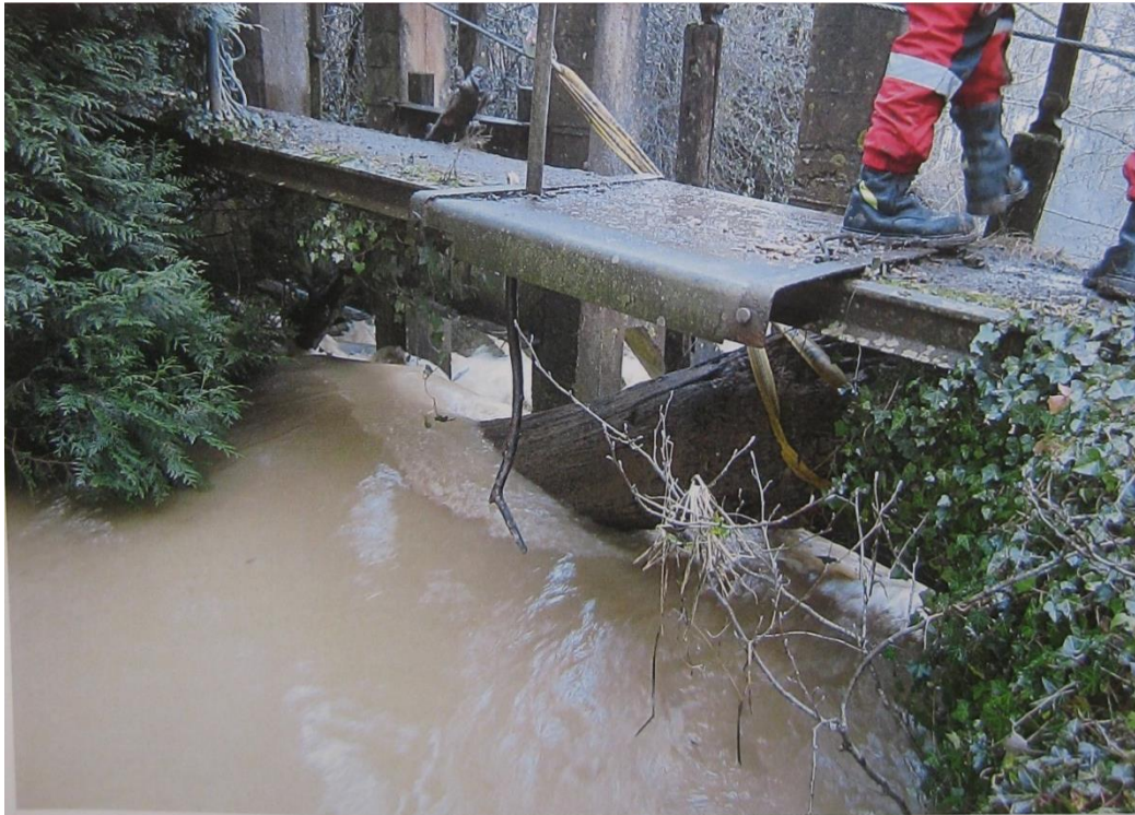
Figure 14 : Arbre pris dans la vanne au moulin de la Ferté en 2012
