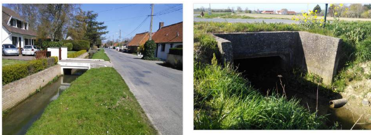
Figure 13 : Exemple de becques et de passage sous un axe routier caractérisant les coteaux
