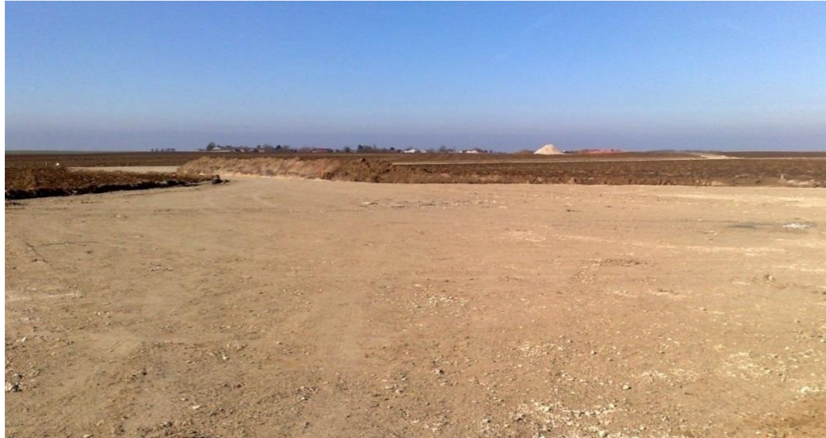
Figure 132 : Exemple d'aire de montage, grave compactée sur géotextile
