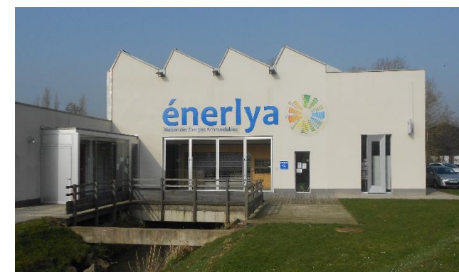
Figure 108 : ENERLYA – Fauquembergues (©ATER Environnement)
