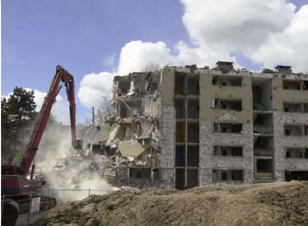
Conventions ANRU - Démolition à Boulogne-sur-Mer
